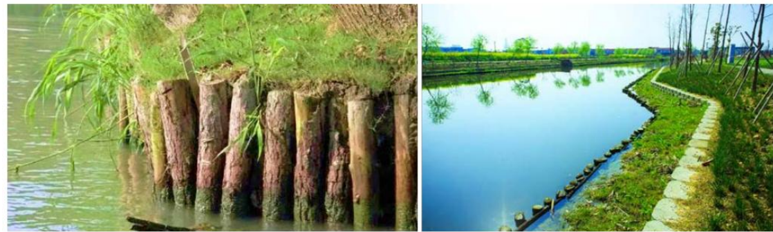
图 3.2-5 松木桩生态护岸实施效果实景图
